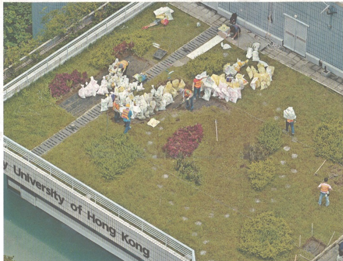
因黃雨影響，工人昨只移除鄭翼之樓天台部分植被。
