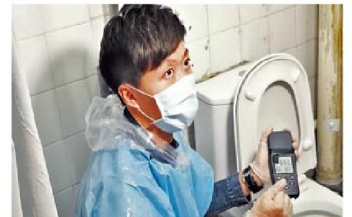
▲銀進工程及測試有限公司測試主管劉少雄示範喉管氣體檢測法。
