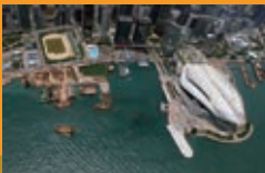
Civil Engineering 土木工程 Central-Wan Chai Bypass at Wai Chai East & HKCEC 中環灣仔繞道灣仔東段及香港會議展覽中心東段
