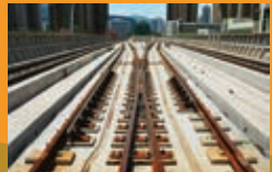
Trackwork Engineering 路軌工程 East Rail Ma On Shan Extensions 東鐵綫鞍山延線
