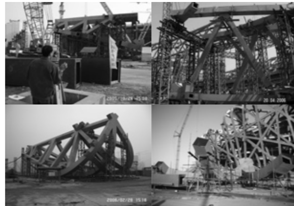
圖2 鋼構件拼裝測量
